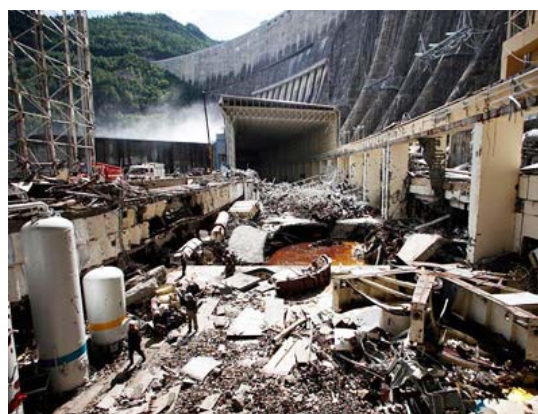
Рисунок 2. – Причина аварии на Саяно-Шушенской ГЭС – многократное возникновение дополнительных нагрузок переменного характера на гидроагрегат
