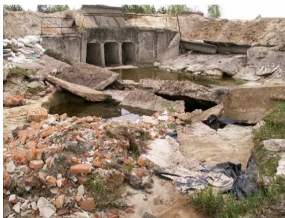
а) б) а) состояние берегозащиты (общий вид с правого берега); б) вид на автоматический водосброс;
