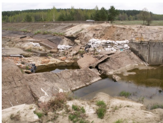
а) б) а) состояние берегозащиты (общий вид с правого берега); б) вид на автоматический водосброс;
